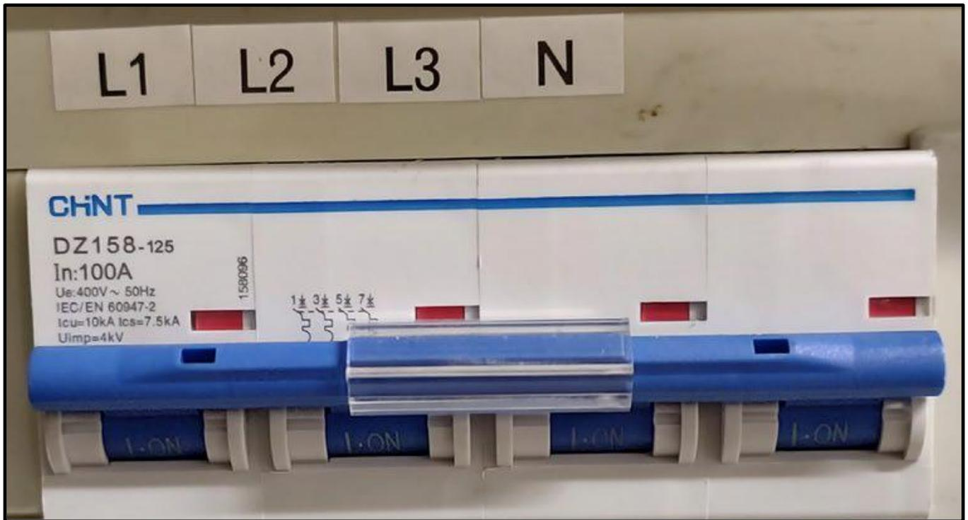
*Interruttore magnetotermico (4P / 125A / 10kA / Curva C) installato all'interno della Cabina Elettrica*
